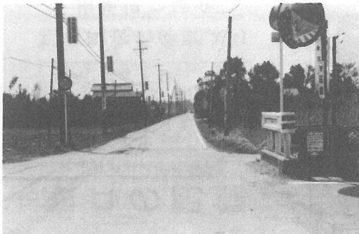
▲歩道設置工事が待たれる町道鳥喰新田線(横芝小下)
