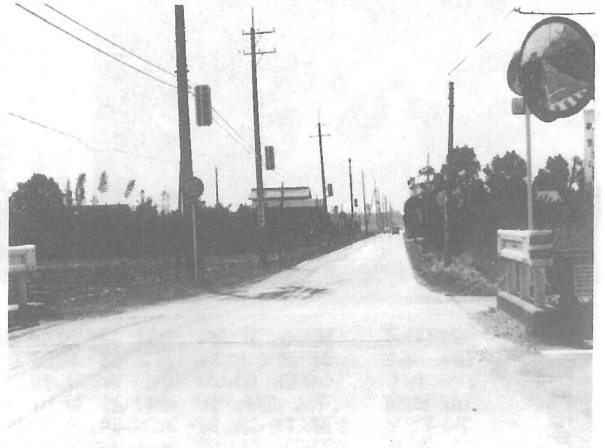
歩道が設置される横芝小下の幹線町道
