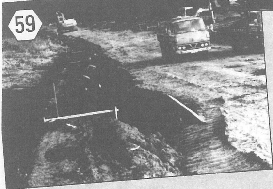
▼ 産業開発道路建設工事始動
