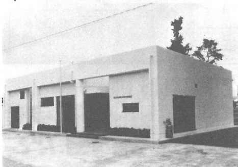
完成した東町共同利用施設
