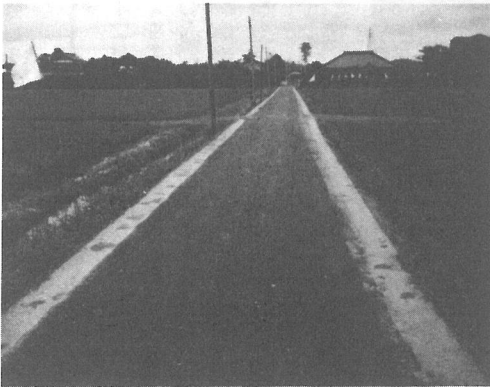
舗装補修工事成済の鳥喰沼線
