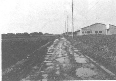
新島の農道整備事業現場
