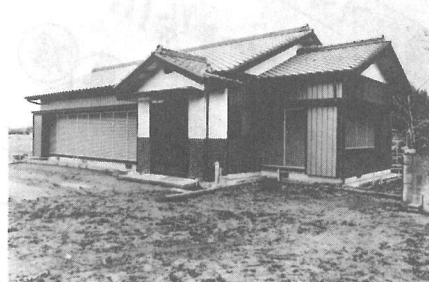
【完成した鳥喰地区の集会施設】
