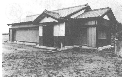
【完成した鳥喰地区の集会施設】
