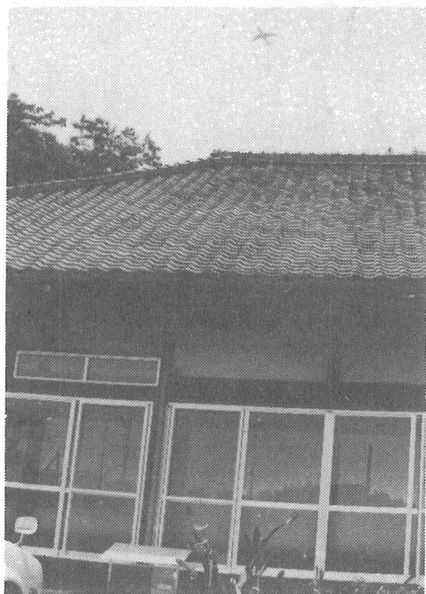
▲防音工事が実施された家屋(中台)
