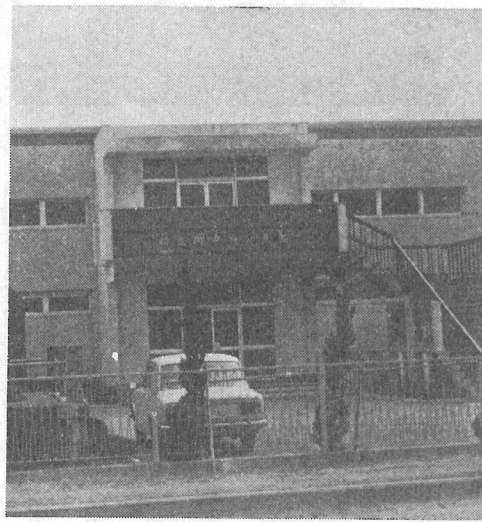
完成した町中央公民館
