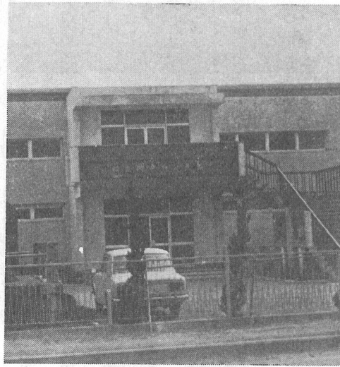
完成した町中央公民館
