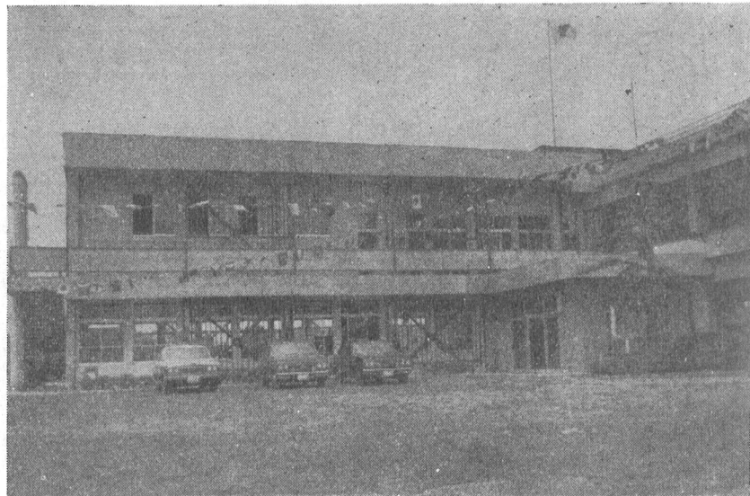
庁舎増築部全景
