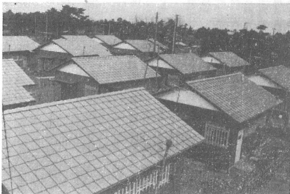
写真は栗山地区、青芝会のとなり新しく完成した二十戸の町営住宅です。ここに入居した人たちは、新に隣組部落を結成しました。名称は四五会、この住宅建設資金の一部には簡易生命保険の積立金が郵政省よりの借入金として利用されています。
