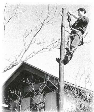
有線放送の工事風景（昭和35年）
