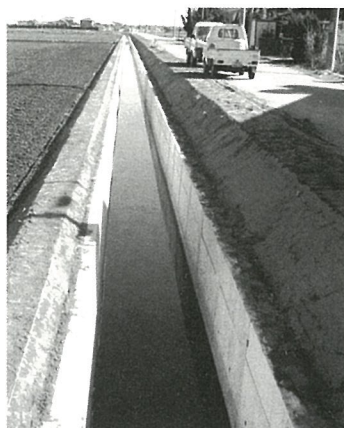
◀地元の方々の協力により完成した排水路
