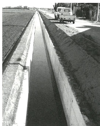
◀地元の皆さんの協力により完成した排水路
