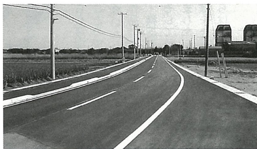
道路改良が進む町道0110号線(白磯)
