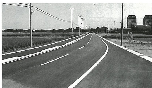
道路改良が進む町道0110号線（白磯）
