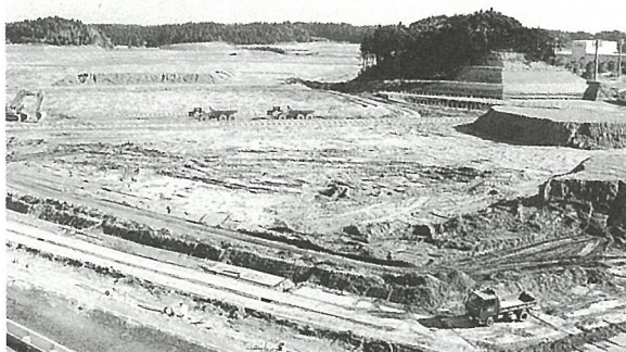
造成が進むひかり工業団地
