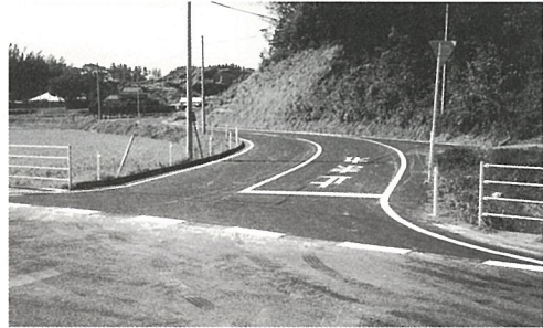
今年完成した町道0101号線（篠本一区地先）
