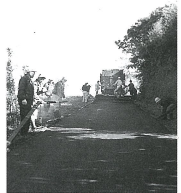
集落内未舗装道路は直営舗装で実施します。
