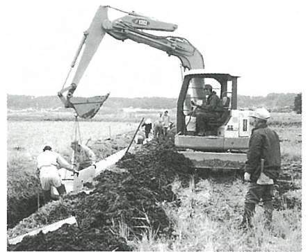
排水路の整備は、資材交付または請負工事の方法で対応していきます。
