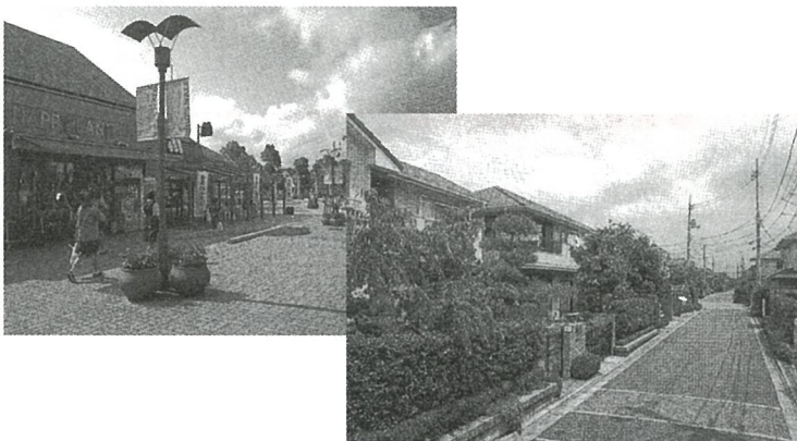
土地区画整理事業により整備された街並み
