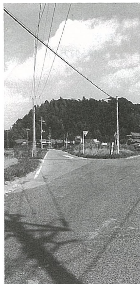
今年度測量や地質調査など を行う町道0102号線
