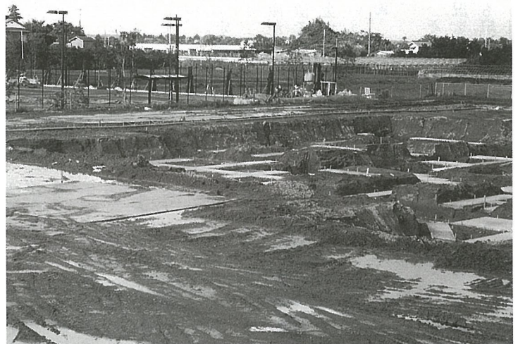
工事が始まった(仮称)複合スポーツ施設
