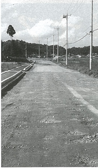
着々と工事の進む町道0103号線
