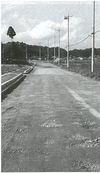
着々と工事の進む町道0103号線
