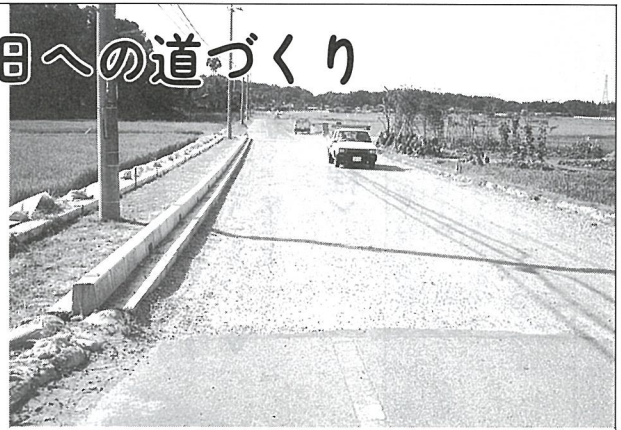
▲ 拡幅工事が進む0103号線 (小田部地先)
