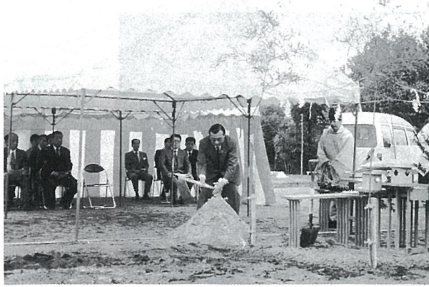
▲関係者により起工式が行われ、鍬入れをする町長
